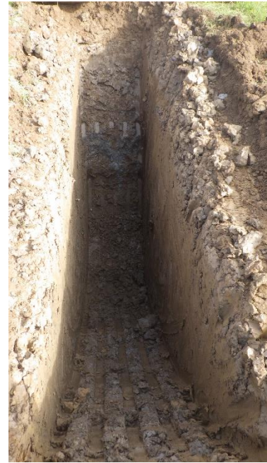
Figure 5 H:\2020-WW-102 Arklow Bank\Arklow Bank Tp Photos\TP02(2).JPG
