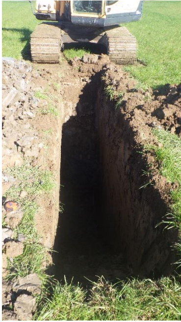
Figure 1 H:\2020-WW-102 Arklow Bank\Arklow Bank Tp Photos\TP01(1).JPG
