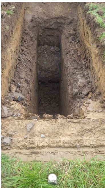
Figure 21 H:\2020-WW-102 Arklow Bank\Arklow Bank Tp Photos\TP09(1).JPG
