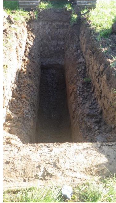
Figure 23 H:\2020-WW-102 Arklow Bank\Arklow Bank Tp Photos\TP10(1).JPG
