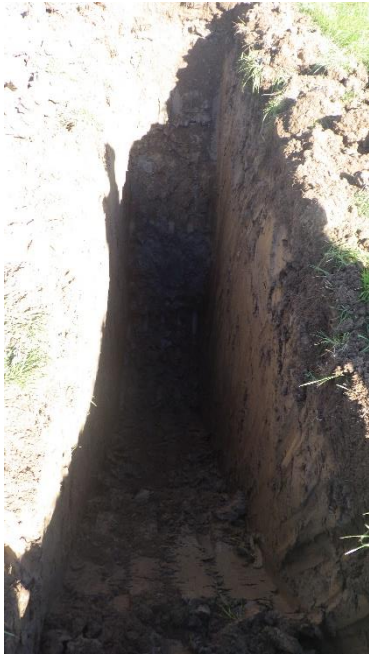
Figure 2 H:\2020-WW-102 Arklow Bank\Arklow Bank Tp Photos\TP01(2).JPG
