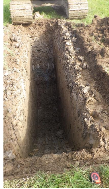
Figure 4 H:\2020-WW-102 Arklow Bank\Arklow Bank Tp Photos\TP02(1).JPG
