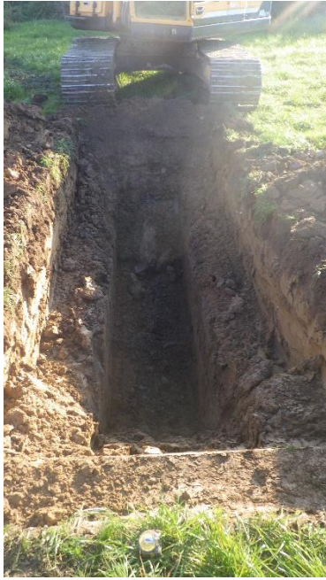
Figure 13 H:\2020-WW-102 Arklow Bank\Arklow Bank Tp Photos\TP06(1).JPG
