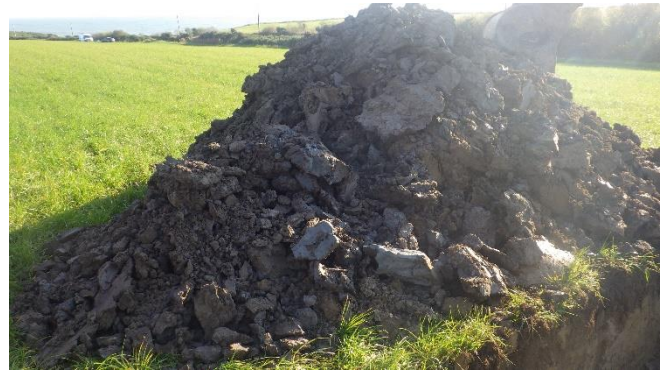
Figure 28 H:\2020-WW-102 Arklow Bank\Arklow Bank Tp Photos\TP11(3).JPG
