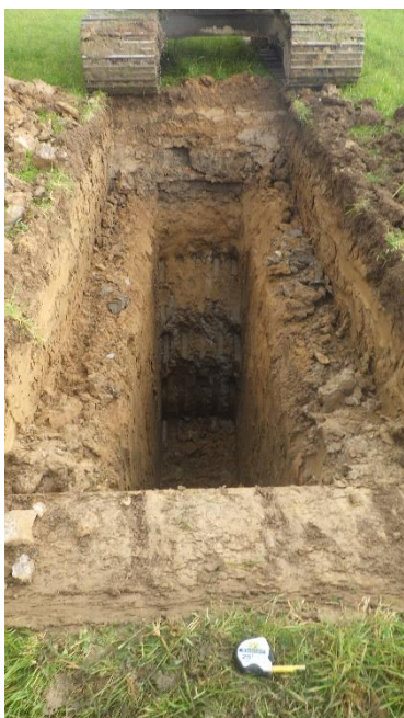
Figure 9 H:\2020-WW-102 Arklow Bank\Arklow Bank Tp Photos\TP04(1).JPG
