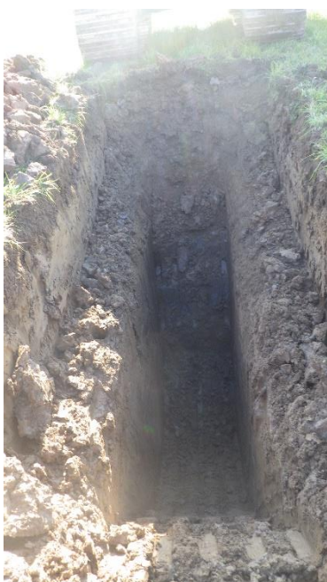
Figure 27 H:\2020-WW-102 Arklow Bank\Arklow Bank Tp Photos\TP11(2).JPG
