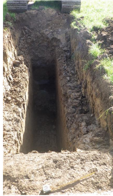
Figure 16 H:\2020-WW-102 Arklow Bank\Arklow Bank Tp Photos\TP07(1).JPG
