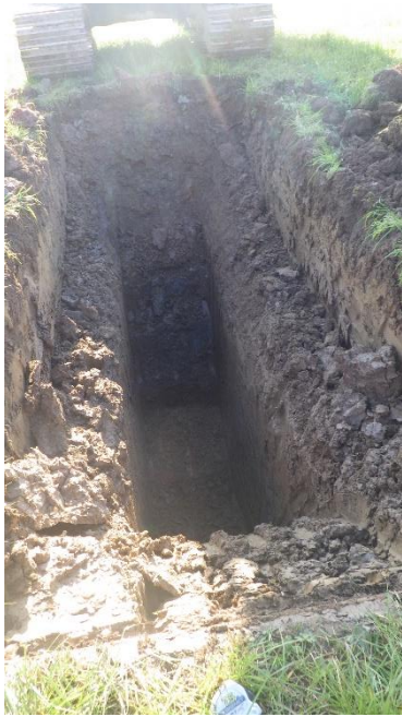
Figure 26 H:\2020-WW-102 Arklow Bank\Arklow Bank Tp Photos\TP11(1).JPG
