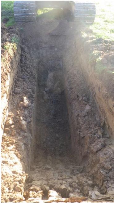
Figure 14 H:\2020-WW-102 Arklow Bank\Arklow Bank Tp Photos\TP06(2).JPG
