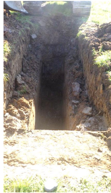
Figure 29 H:\2020-WW-102 Arklow Bank\Arklow Bank Tp Photos\TP12(1).JPG
